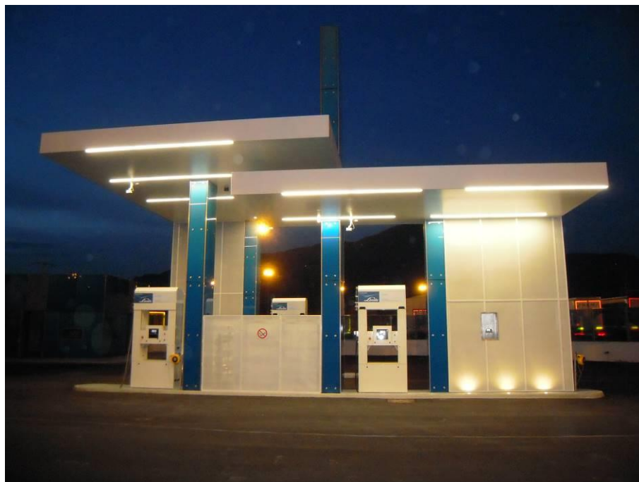
Abb. 29: Wasserstoff-Tankstelle an der Mautstelle Bozen Süd. Quelle: Bottoli, 2018 .
